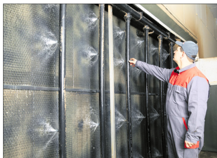
Kaspar Sigrist beim Biowäscher, wo die Luft in einem dreistufigen Verfahren gereinigt wird.
