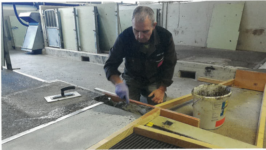
Abb. 2: Vorbereitungsarbeiten durch MLP-Mitarbeiter Sepp Huber für optimale Platzierung der neuen Station.
