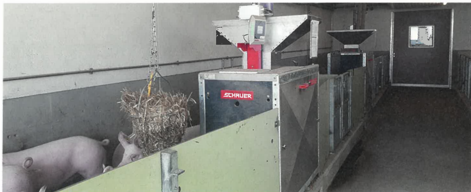
Abb.4: Schauer-Station fertig montiert und in Betrieb genommen.
