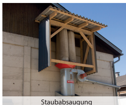
Übergabeeinheit mit Staubabscheidung
